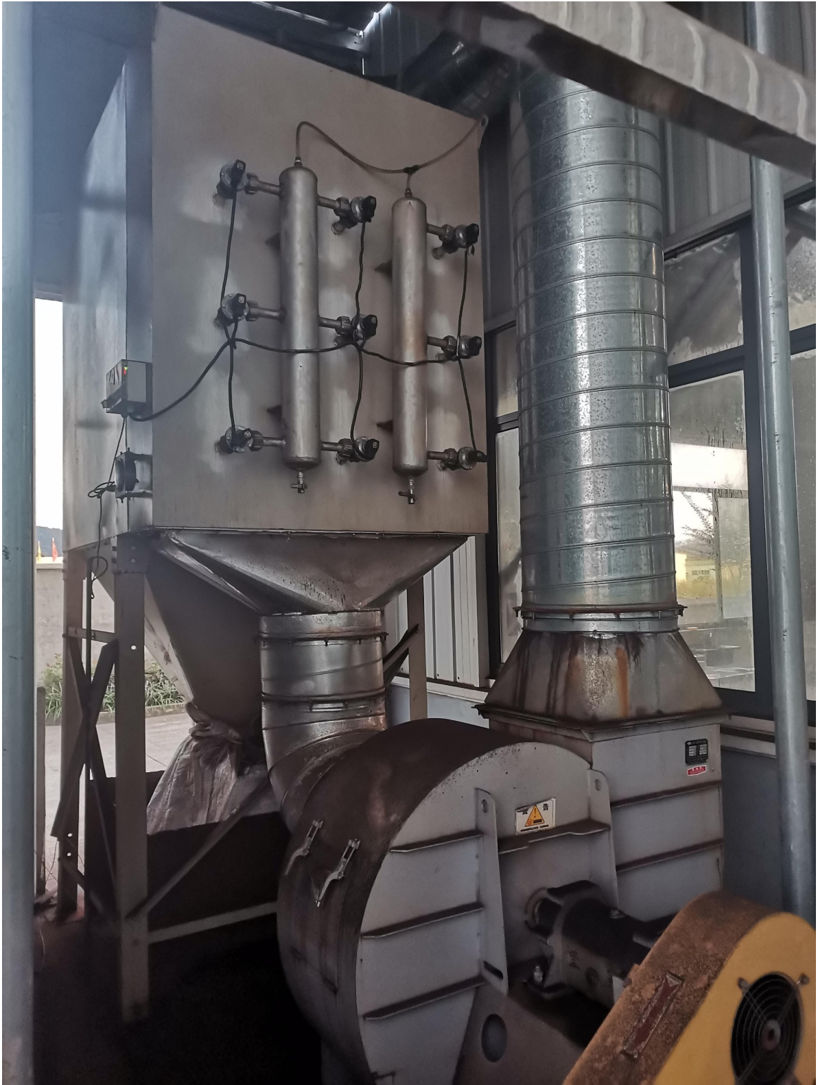
等离子切割废气处理设施照片
