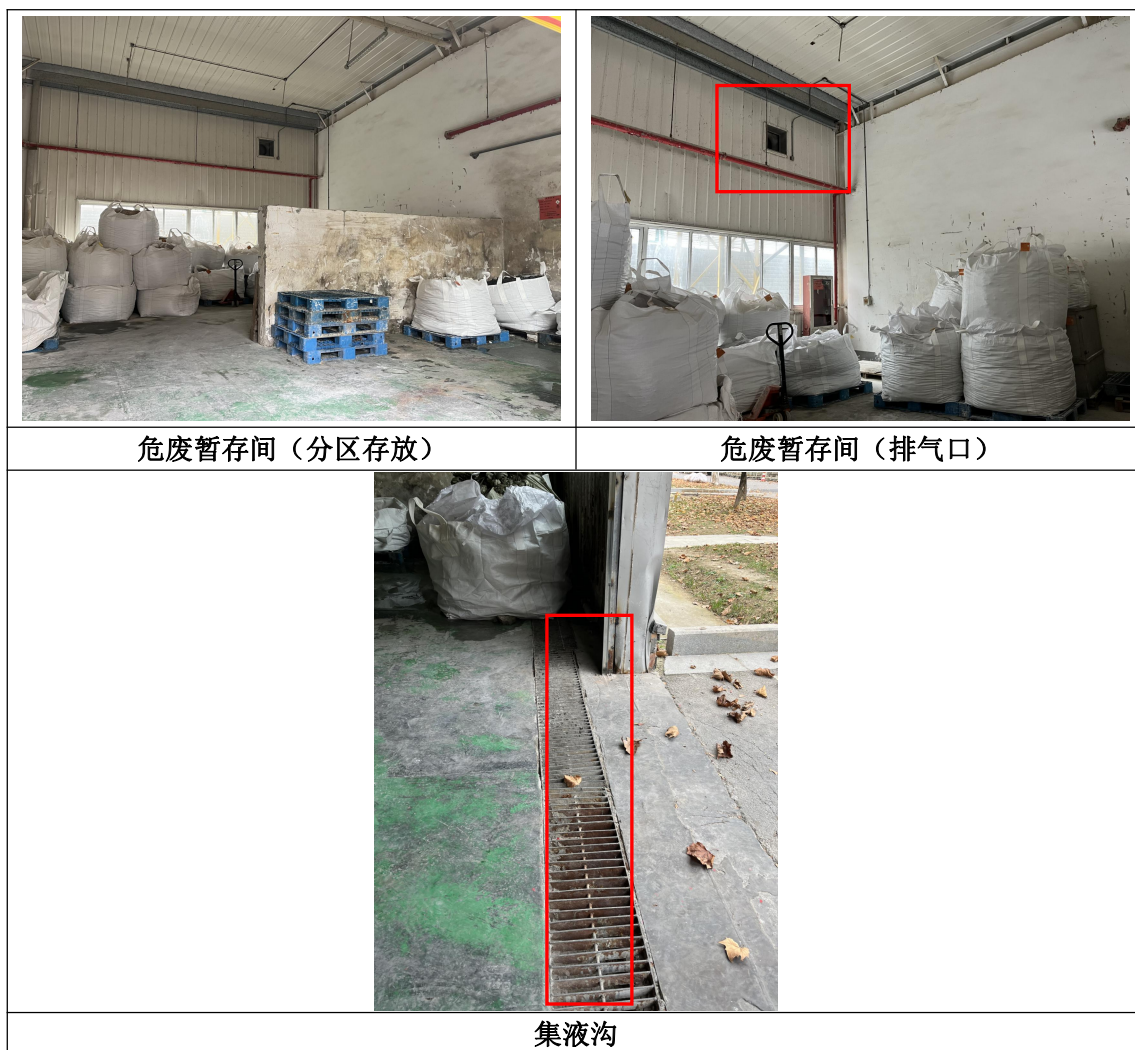
图 4.1-5 危险废物暂存间照片
