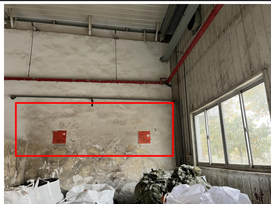
危废暂存间（内部标识）
