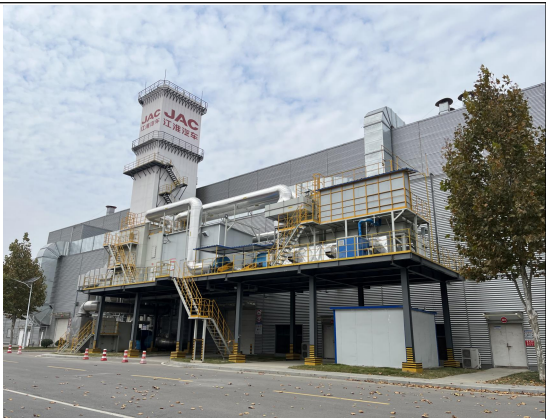
喷漆废气沸石转轮+RTO 装置
